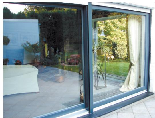
**K:** Bei der Hebe-Schiebe-Anlage, war uns wichtig, dass sie ebenfalls innen mit der Dekorfolie und außen mit der Aluschale in derselben Optik übereinstimmte.
